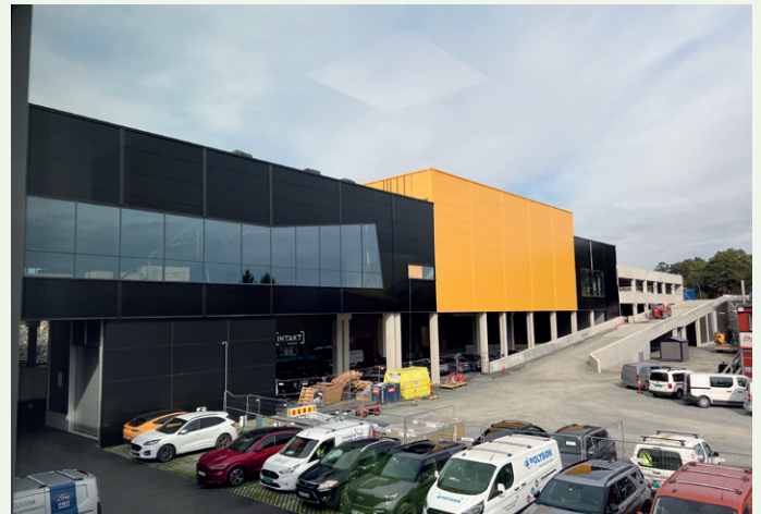
Bak utbyggingen står Stadsporten og Auga Eiendom som har 50/50-eierskap i prosjektet Kokstaddalen 7 AS.
